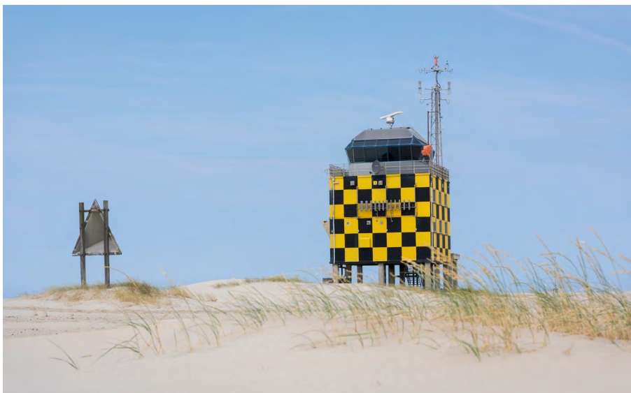
Figuur 14 Controletoren van de Vliehors, geblokt en voorzien van strobeverlichting, met ervoor de radarreflector (bron: Defensie.nl).
